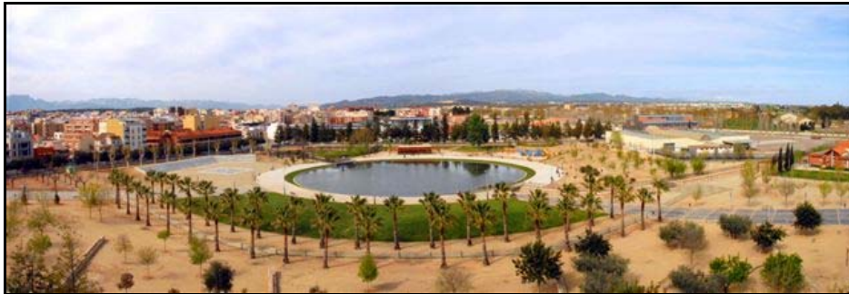
Figura 1. Vista general del “Parc dels Giribecs”
